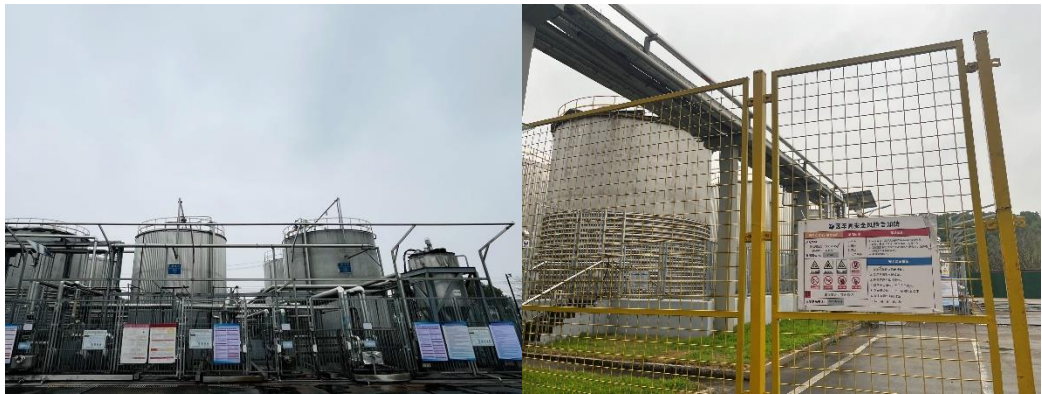
图.储罐区张贴安全告知卡及 MSDS
