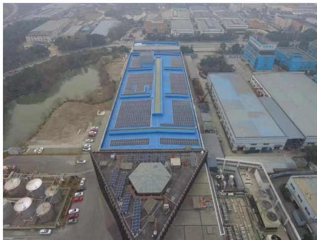
图.公司铺设光伏板图
